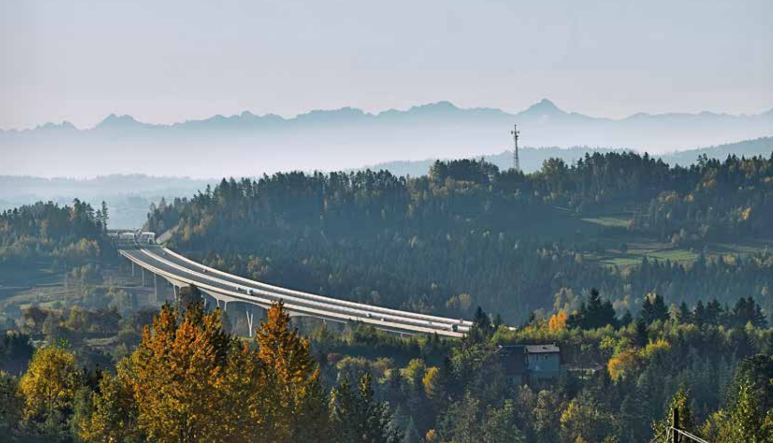
Fot. 5.25. Obszary nowej infrastruktury technicznej, estakada na S7
