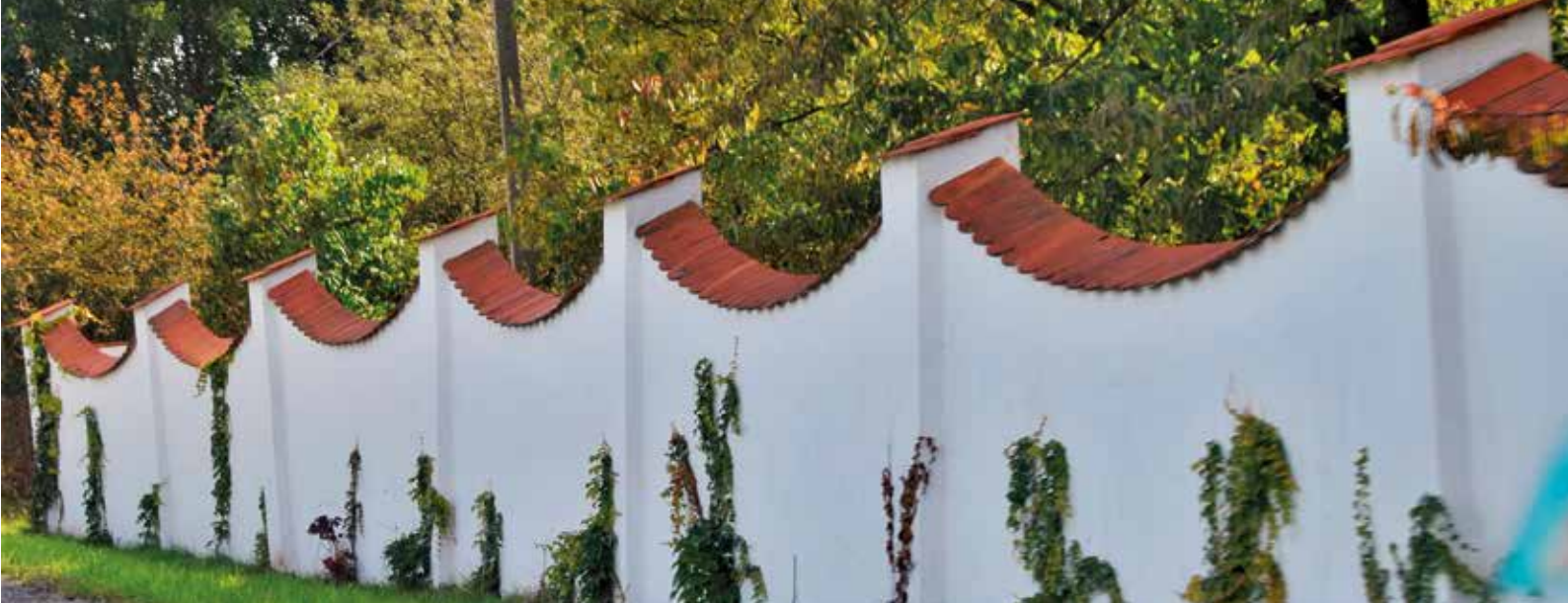
Fot. 5.20. Kulturalnie zaprojektowane ogrodzenia, Brzoskwinia, pow. krakowski
