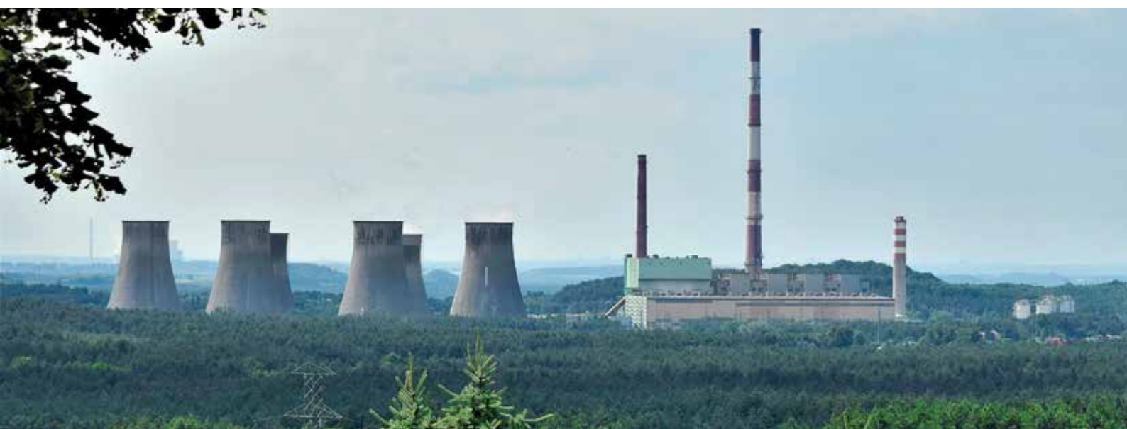
Fot. 2.28. Typ 12 Przemysłowe i energetyczne, Podtyp 12a Duże kompleksy przemysłowe. Elektrociepłownia Siersza, Trzebinia, pow. chrzanowski
