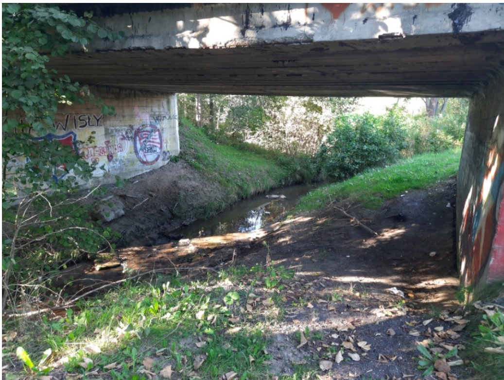
Fot 9. Most nad potokiem Rudno, wykorzystywany przez zwierzęta jako dolne przejście w kierunku północ – południe doliną cieku
